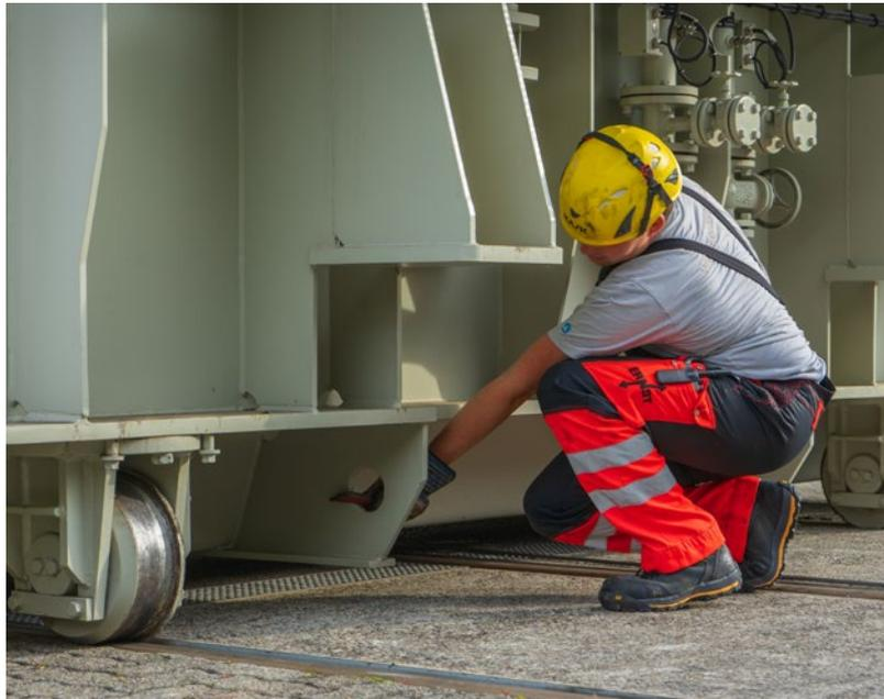
Schienenstränge. Statt ihn mit einem riesigen Kran zu hieven, verschieben sie den Trafo, der dafür passende Räder besitzt, direkt über diese Schienen an seinen neuen Wirkungsort.
