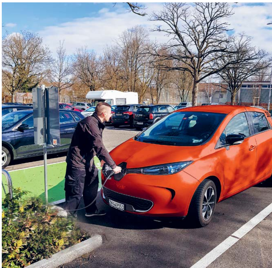
Bereits im vergangenen Dezember dem Betrieb übergeben: die Ladestation an der Oberhauserstrasse.
