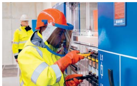
2019 rund 2,1 Millionen Franken in die Netzinfrastruktur investiert.
